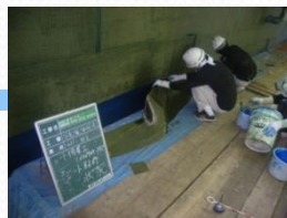
② シート貼付
