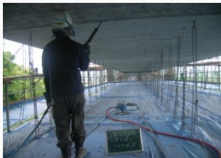
下地処理作業
